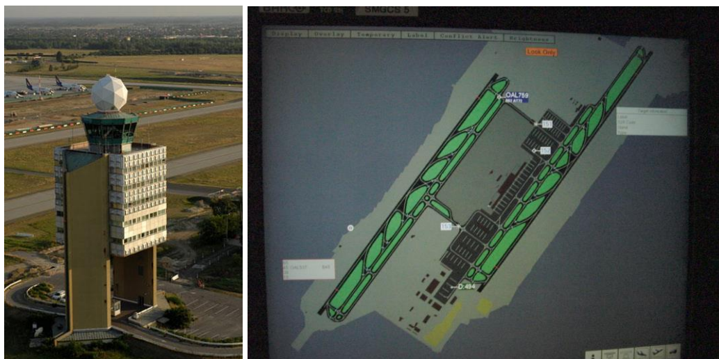
7. ábra Egy irányítótorny (Budapest) tetején elhelyezett gurítóradar és egy jellegzetes gurítóradar-kép
