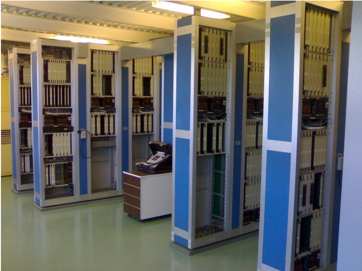
A MH Központi Katonai kórház „A” épület alagsorában telepített EP-128 az új vezérlővel
