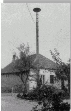
Vasbeton oszlopra telepítve
