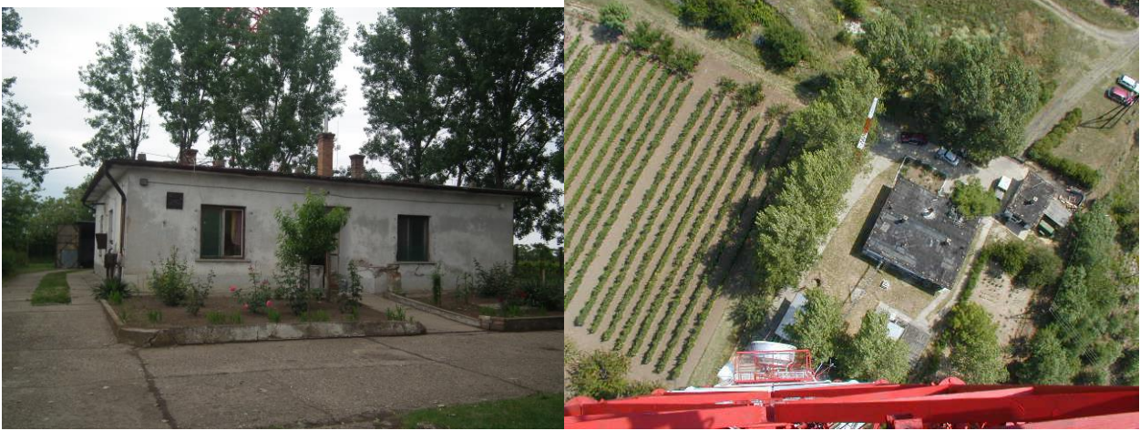
A dunaföldvári átjátszó állomás épülete előlről és fentről
