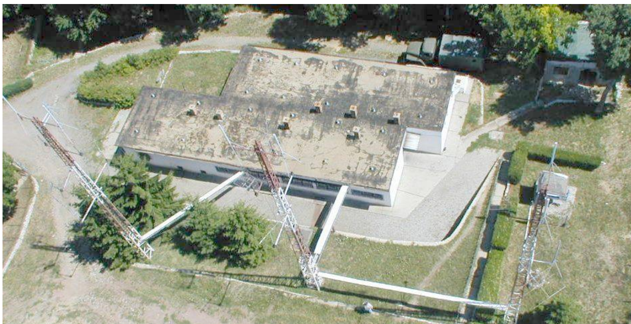
Pécs, Tubesen lévő átjátszó állomás a később létesített három antenna tartóval NEKTÁR csatlakozó állomásként az R-405, R-1406 antennákkal és URH gyári antennákkal
