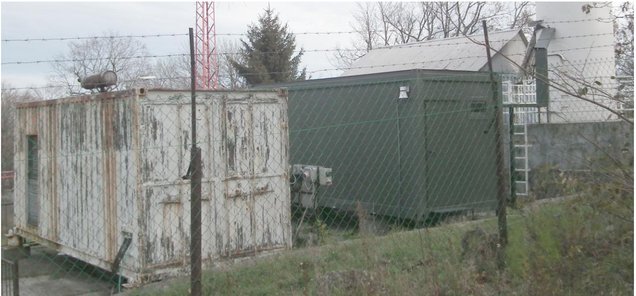
Tubezen elhelyezett aggregátor (baloldali) és adóállomás konténerek
